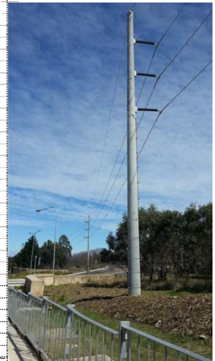
132kV Pole Relocation
